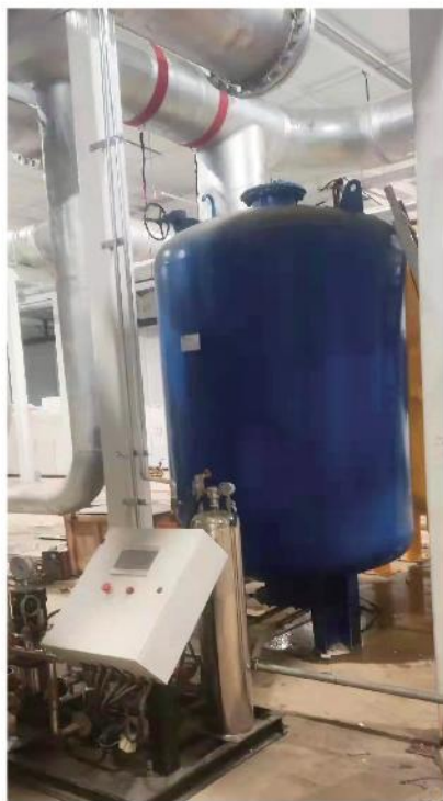
定压补水真空脱气机组
