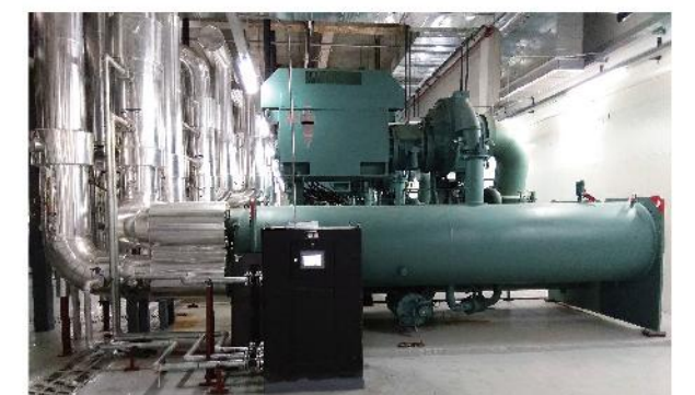
冷凝器胶球自动在线清洗装置
